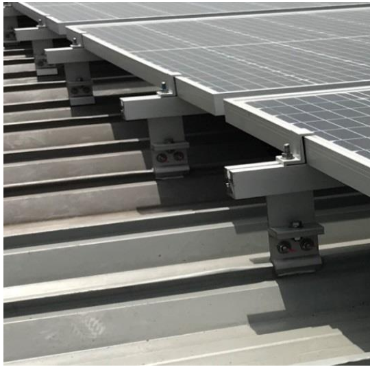
太陽能板730B型彩色鋼板固定夾具
