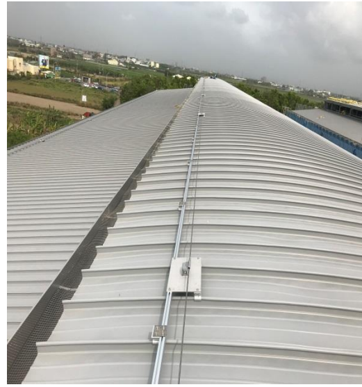
台鐵台中站CCL531標九個站貓道. 安全母索扣桿
