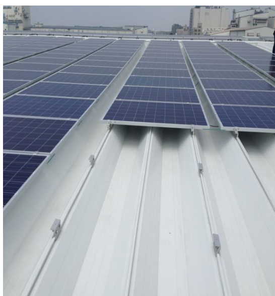
太陽能板500型彩色鋼板固定夾具
