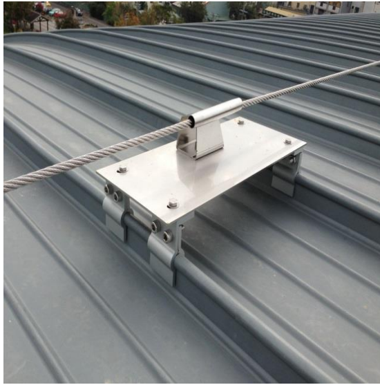
台鐵台中站CCL531標九個站貓道. 安全母索扣桿
